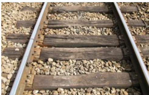
Rails courts sur traverses bois
